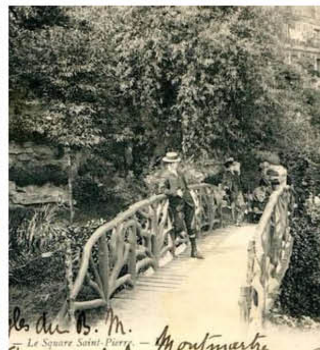
Images de référence - pont rustique square Saint-Pierre
