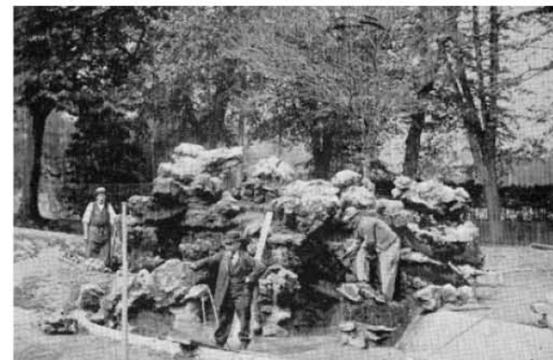
Rocher en construction au Parc de la Pépinière par J. Picoré.
