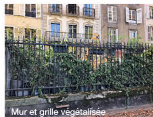
Les façades rue des Écuries
