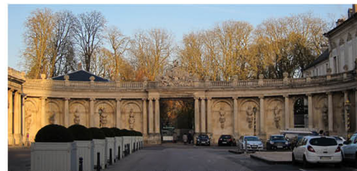
Vue des Tilleuls de la Terrasse depuis l'Hémicycle De Gaulle
